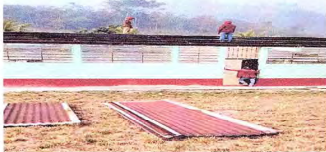
Foto 1: Rehaibilitacion de estrucctura metalica de la escuela.
