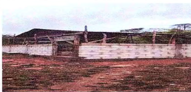
Foto 4: Proceso de levantamiento de nuevo del aula.
