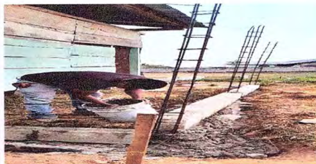
Foto 2: Inicio de rehabilitacion de aula.
