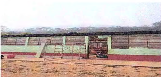
Foto 3: Proceso de desinstalacion de entechado.
