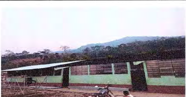
Foto 5: Vista frontal del entechado de la escuela.
